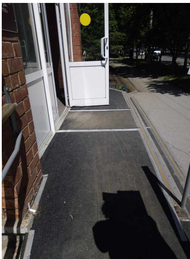
Фото 4 Входная площадка (перед дверью)
